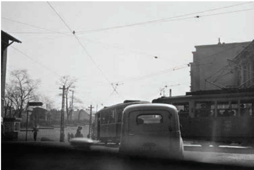
↑ 1956. Ulica 22 Lipca, wjazd pod wiadukt kolejowy od strony Starego Sosnowca
