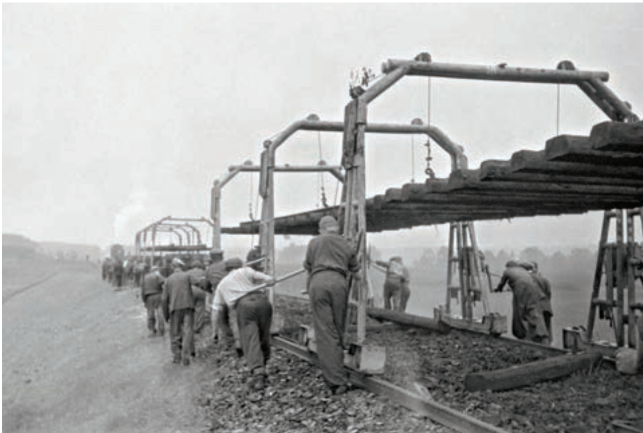
↑ Budowa kolei piaskowej (służącej zamulaniu nieczynnych chodników kopalni) w dzielnicy Jęzor. Układanie podkładów kolejowych
