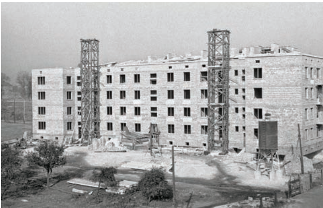
↑ 1956. Budowa hotelu robotniczego kopalni Niwka-Modrzejów
